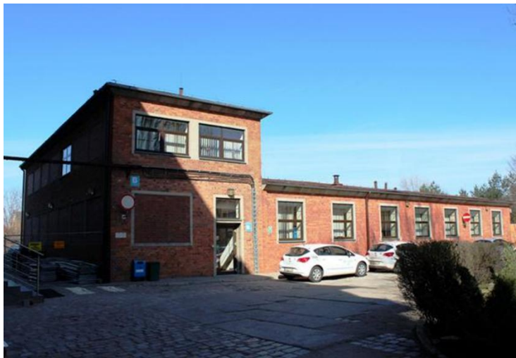
Budynek warsztatów, ob. biurowy w zespole wodociągów miejskich "Na Grobli"; ul. Na Grobli (2015 r.)
